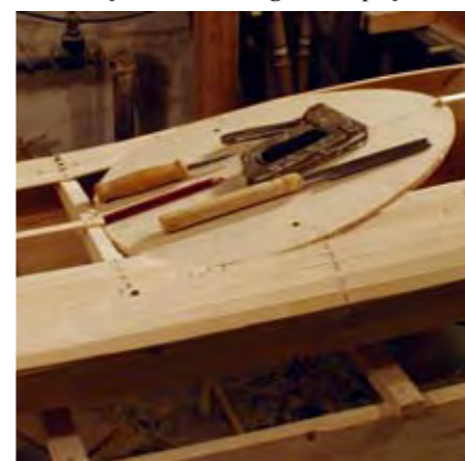
Ribba antingen utifrån (enklast) eller inifrån (snyggast). Här följer ribborna relingen i en elegant bågform
